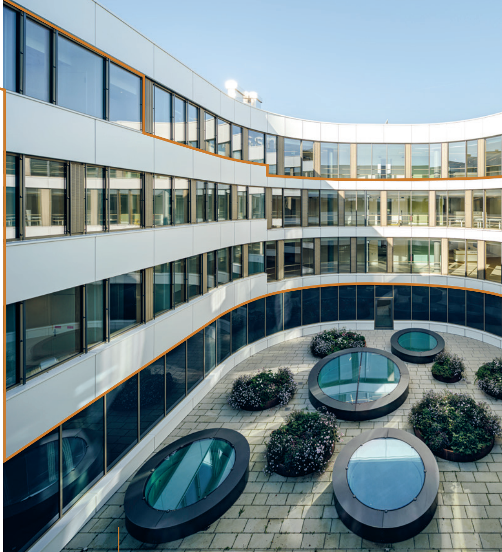
La société Ghisleni Partner AG était chargée de la conception générale, de la gestion de la construction et du BIM pour la construction du nouvel hôpital cantonal de Baden. (Photo : Silvano Pedrett)
